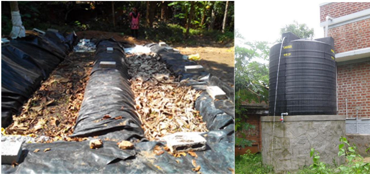
Et low cost bio-filtreringsanlæg er under konstruktion nær 'girls hostel'. Formålet er især demonstration. Nye tanke til opsamling af regnvand er etableret ved alle større tagflader.
