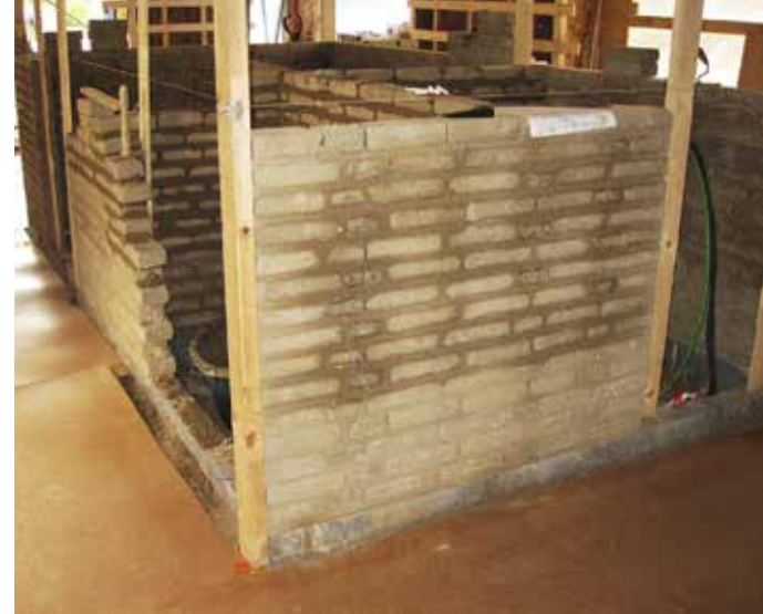
▲ Opmuring af lerstensvægge omkring badeværelse og teknikrum midt i huset giver en kerne af ler, der bidrager til et godt indeklima. FOTO: JETTE HAGEN-SEN
