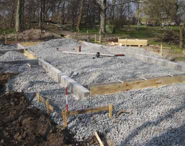
◀ Fundamentet støbes som et smalt randfundament under ydermuren for at spare beton. Terrænisolering af Technopor ses ved siden af fundamentet. FOTO: JETTE HAGEN-SEN
